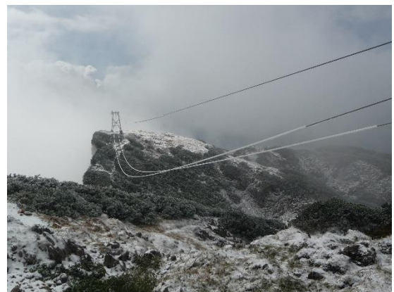
Schneelast sorgt für Seilrisse am Zugseil
